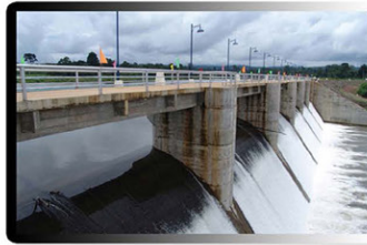
ເຂື່ອນໄຟຟ້າເຊເສັດ 2 ກຳລັງຕິດຕັ້ງ 76 MW XESET 2 HPP, 76 MW
