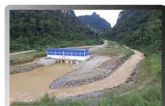
ເຂື່ອນໄຟຟ້ານ້ຳສະນາ ກຳລັງຕິດຕັ້ງ 14 MW NAM SANA HPP, 14 MW
