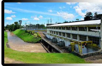
ເຂື່ອນໄຟຟ້າເຊເສັດ 1 ກຳລັງຕິດຕັ້ງ 45 MW XESET 1 HPP, 45 MW
