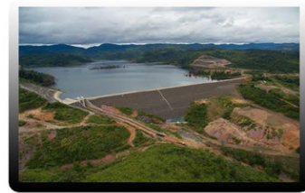
ເຂື່ອນໄຟຟ້າດ້ວຍລຳພັນໃຫຍ່ ກຳລັງຕິດຕັ້ງ 88 MW HOUAY LAMPHAN GNAI HPP, 88 MW
