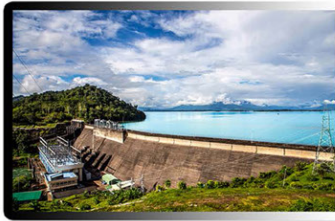
ເຂື່ອນໄຟຟ້ານ້ຳງື່ມ 1 ກຳລັງຕິດຕັ້ງ 155 MW NAM NGUM 1 HPP, 155 MW
