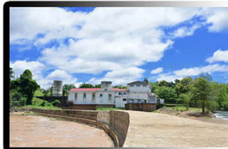
ເຂື່ອນໄຟຟ້າເຊລະບຳ ກຳລັງຕິດຕັ້ງ 5 MW SELABAM HPP, 5 MW
